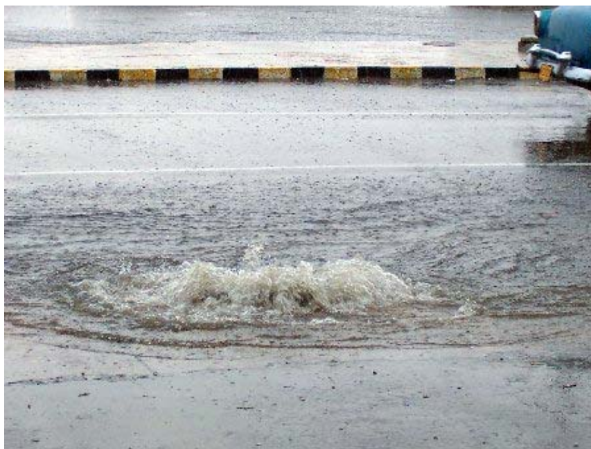
Rete fognaria in pressione con fuoriuscita attraverso chiusino stradale
