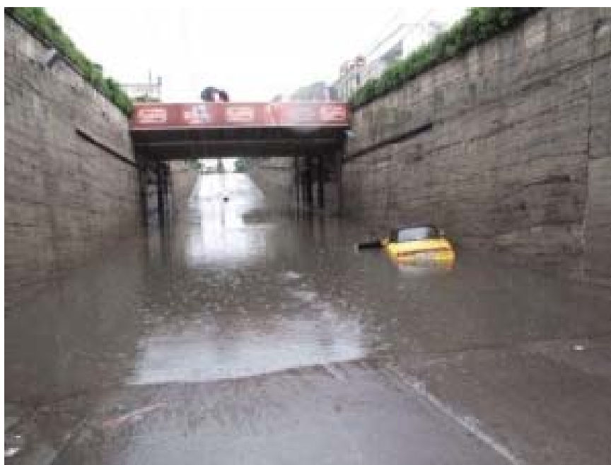
Allagamento di un sottopasso
