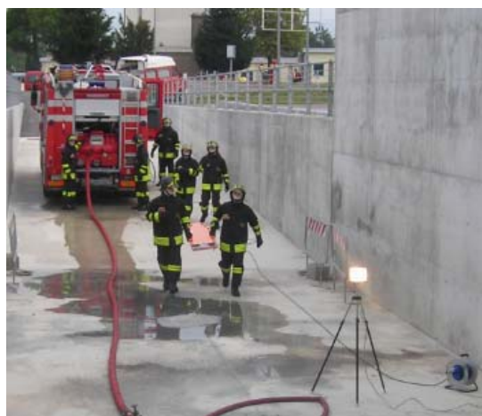
esempio di utilizzo del motogeneratore per la messa in funzione del faro portatile su treppiedi
